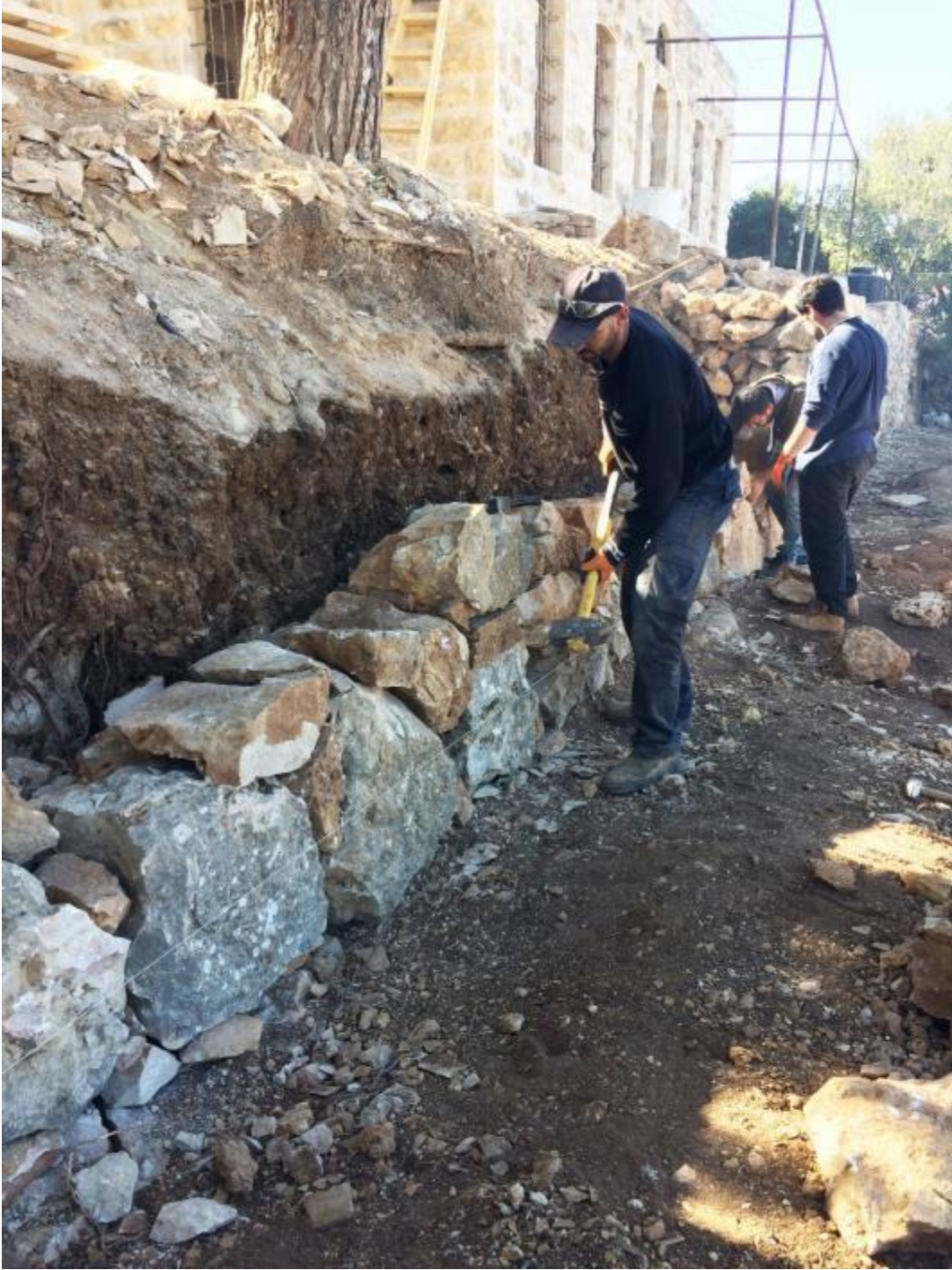
صورة رقم (30): السنسلة أثناء العمل، يتم التحقق من ثبات الحجارة ن خلال الضرب عليها بالمهدة. الصورة ضمن ورشة ساقية حول صيانة السناسل.
