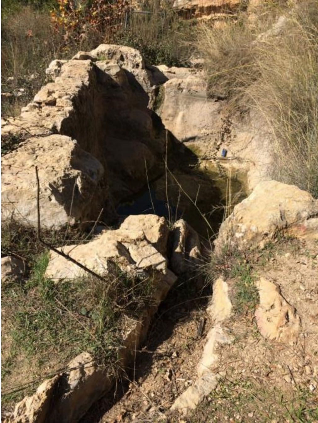
صورة رقم (8): تظهر قناة مبنية من الحجارة، وأرضيتها مقصورة، تستخدم لنقل الماء من عين المجور إلى خزان ماءٍ مفتوحٍ محفورٍ في الصخر. الصورة في منطقة
