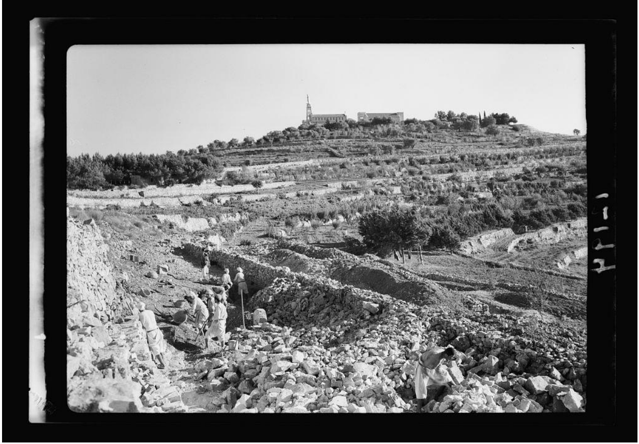
صورة رقم (23): عملية إنشاء سنسلة ومصطبة زراعية، تظهر عملية قلب الأرض لاستخراج الحجارة والتربة وتسوية المصطبة. الصورة في أبو غوش في
