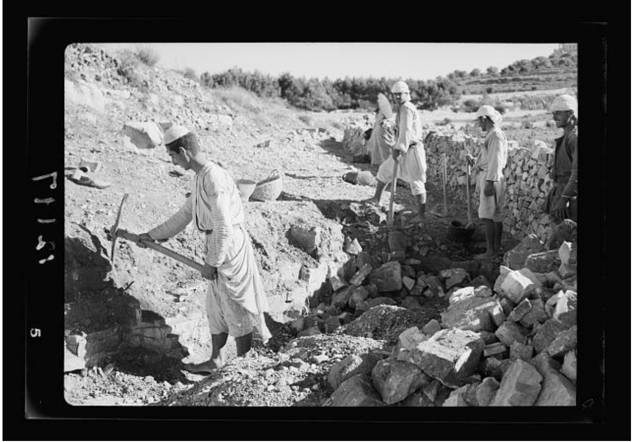
صورة رقم (21): عملية إنشاء سنسلة ومصطبة زراعية، تظهر عملية قلب الأرض لاستخراج الحجارة والتربة وتسوية المصطبة. الصورة في أبو غوش في
